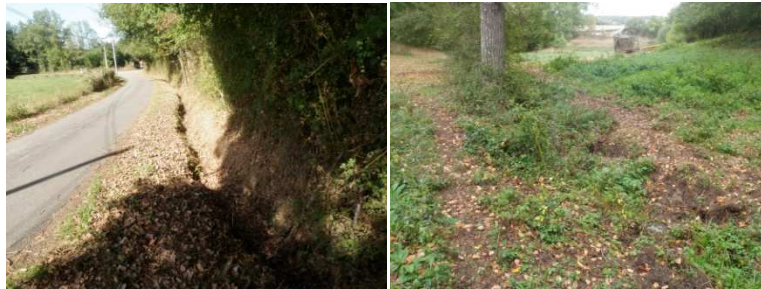
Le ru du Pouget piétiné à l'amont / Ru du Savourenc artificialisé et asséché
